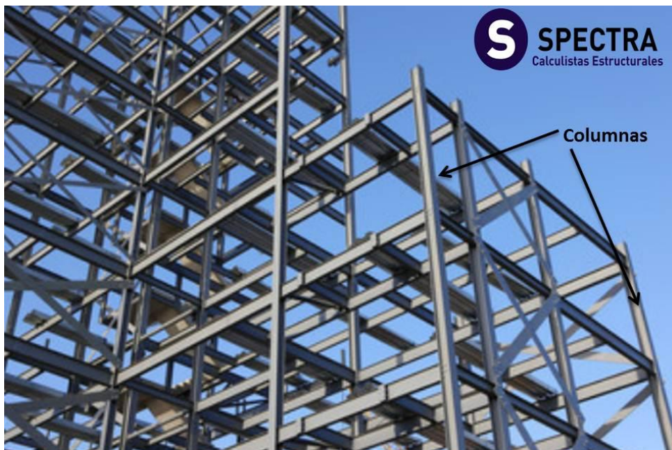
Ubicación de las columnas en una estructura metálica
