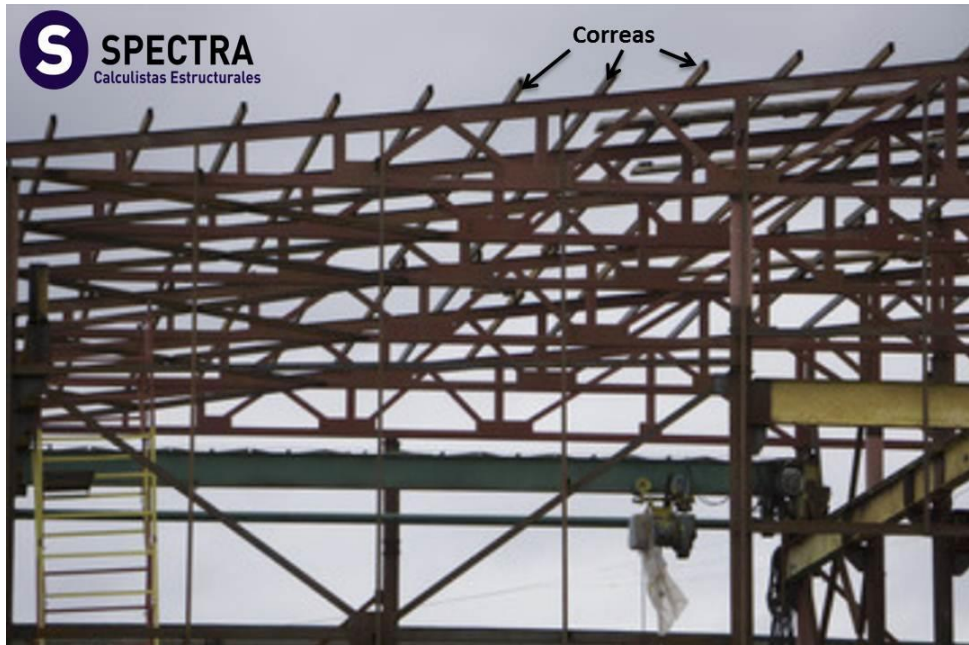
Ubicación de las correas en una estructura metálica
