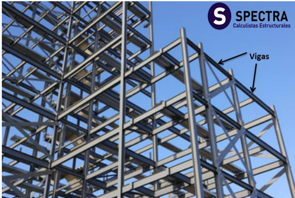
Ubicación de las vigas en una estructura metálica
